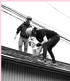
物置小屋屋根の塗装（蚕桑小）
