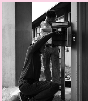
正面玄関ポスト修繕（専修学校）
