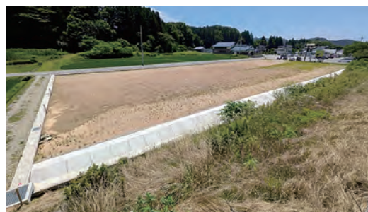
建設を待つ6次産業化拠点施設
