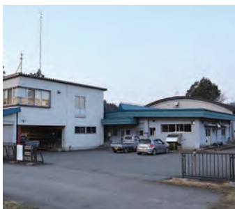
津島台浄水場
