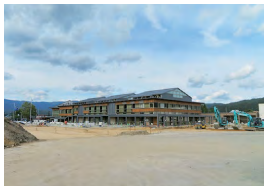
進む外構工事
