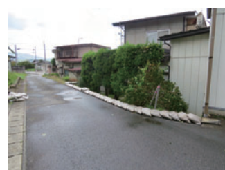
住民の手で積まれた土のう
