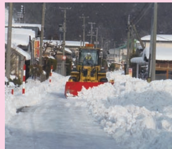
拡幅除雪作業
