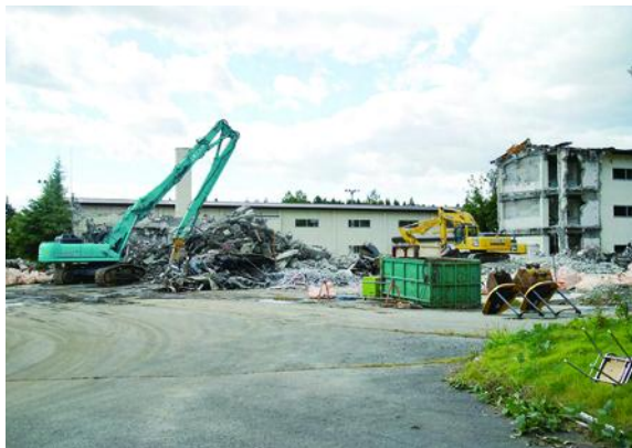
解体が進む旧西中学校
