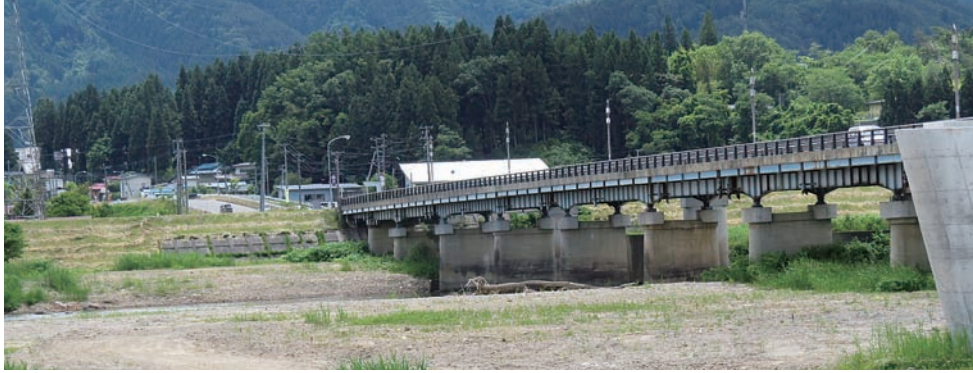
橋脚の完成を待つ
