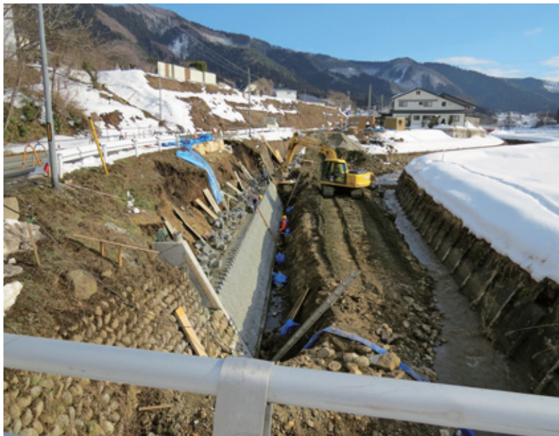
貝生地区の災害復旧現場
