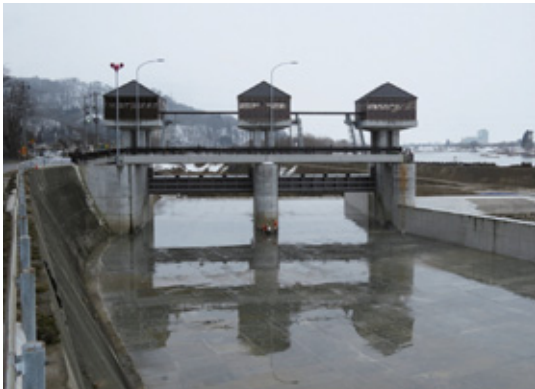
新しくなった諏訪堰頭首工
