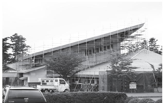
パレス松風の改修状況
