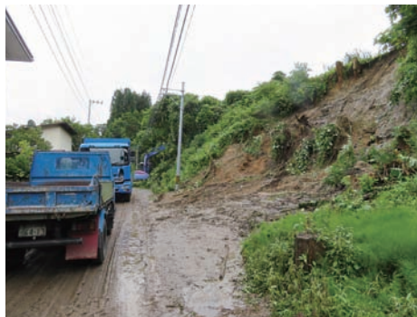
東高玉地区の土砂崩れ
