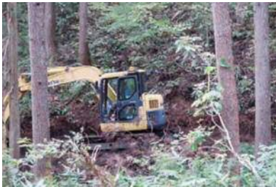
搬出ルート用の道を切り開く ・・・支障木を伐りながら50m/日長さで道を作る
