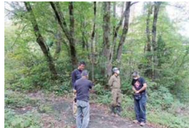
搬出場所を設定後、鉄板を敷き安全化を図る
